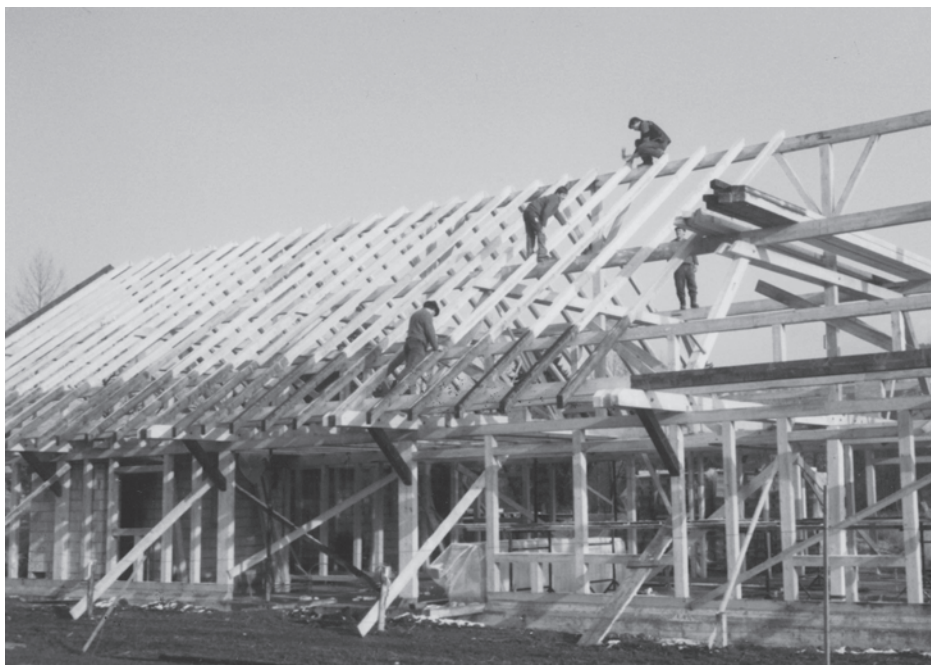
Die eindrückliche Holzkonstruktion nimmt Formen an.
